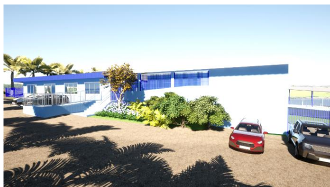
Ampliação e Reforma da Escola Caminho da Estação
