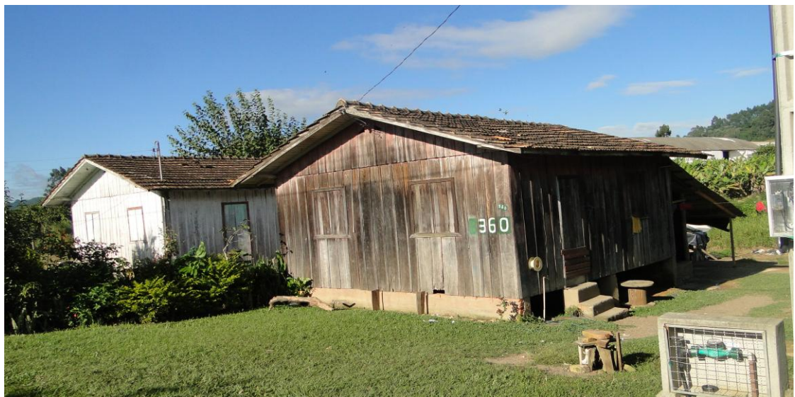
Foto 06 - Vila Empresarial - Rua Celestino Marcelino - área de inundações.
