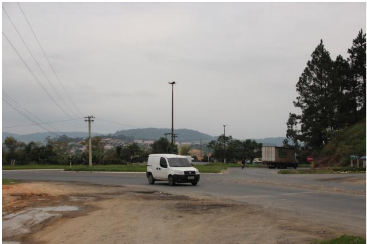
Foto 6 - Trevo de Acesso a Laurentino/Rio do Oeste
