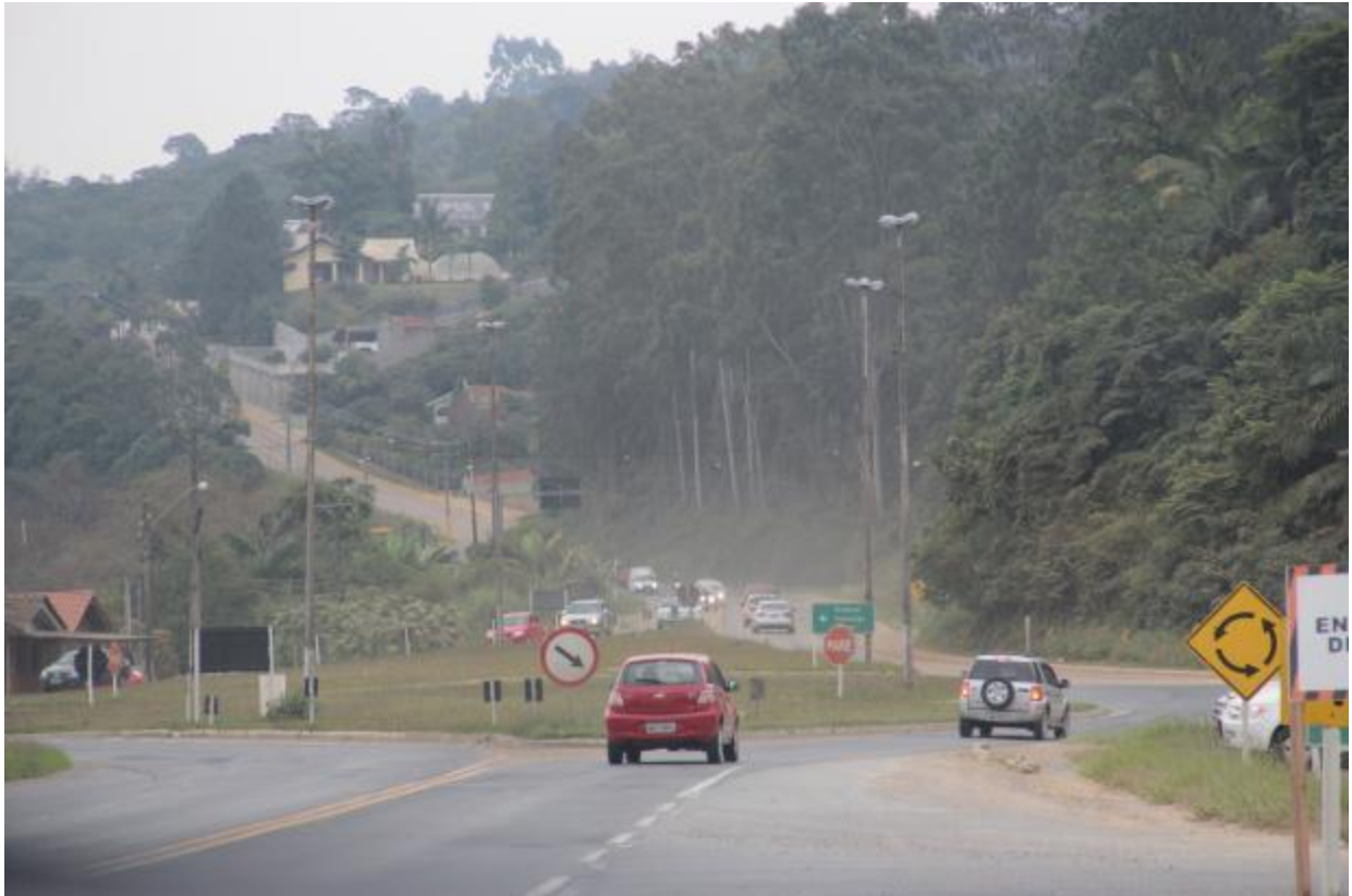
Foto 5 - Trevo de Acesso secundário a Rio do Sul (através do Bairro Canoas)
