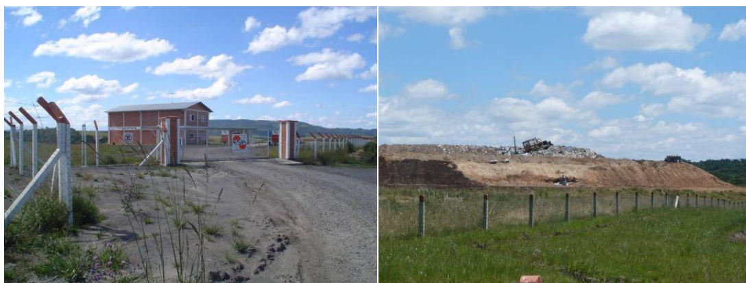
FIGURA 28 – Aterro Sanitário, ESA Ambiental – Lages/SC
