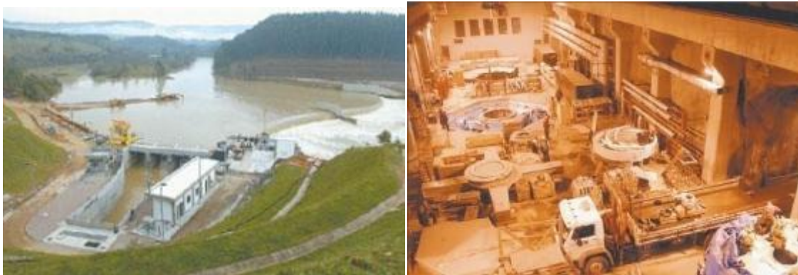
FIGURA 06 – Usina Hidrelétrica de Salto Pilão
