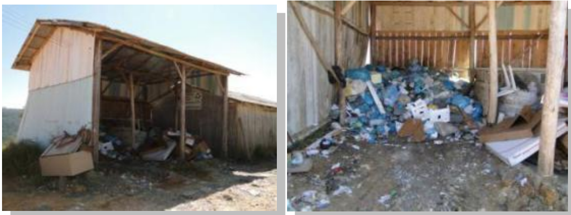
FIGURA 16 – Centro de Triagem de Chapadão do Lageado
