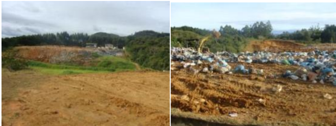
FIGURA 30 – Aterro Sanitário Consórcio Serra São Miguel - Ibirama/SC
