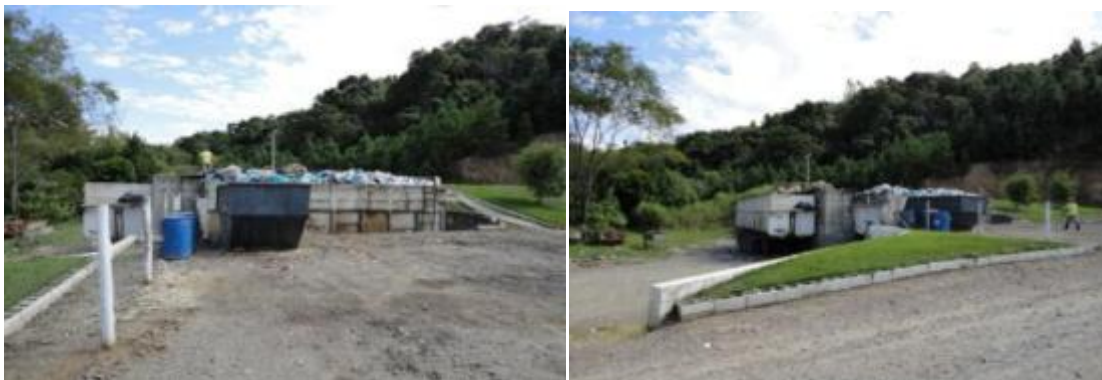
FIGURA 27 – Unidade de Transbordo de Rio do Sul
