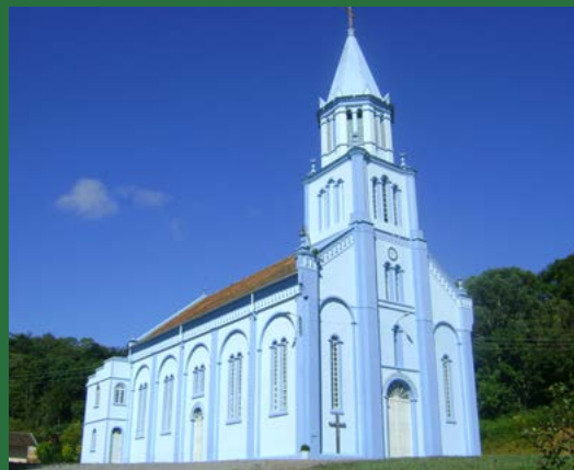
A Igreja de Santa Catarina, na localidade de Toca Grande
